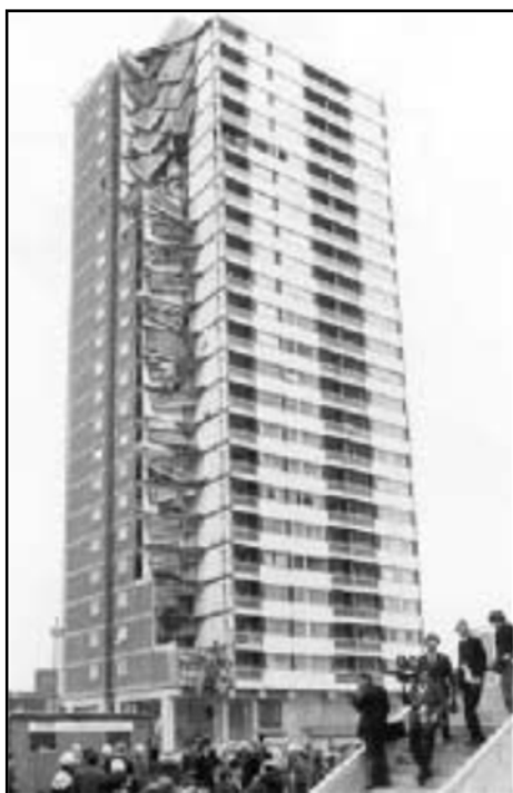
تخریب پیشرونده در ساختمان رونان پوینت انگلیس
